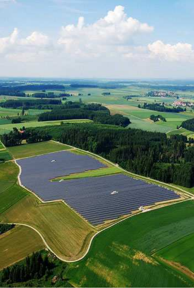
Figure 1 e 2 : impianto fotovoltaico da 6 MWp (oltre 34.000 moduli da 175 Wp, uno dei più grandi in Europa) terminato alla fine del 2007 presso Moorenweis in Baviera (posizione 48° 09' N, 11°04' E
