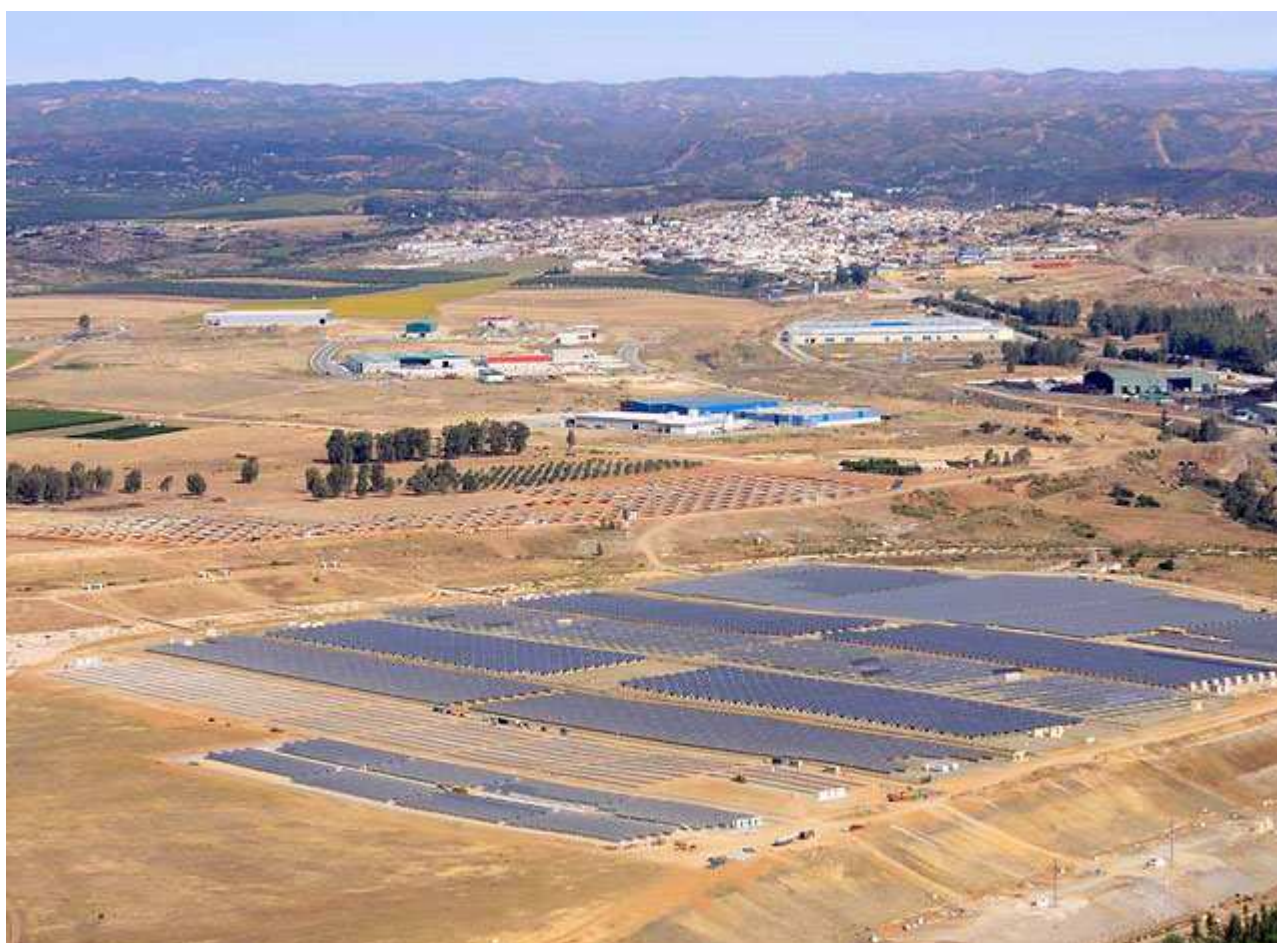
Figura 3: impianto da 2MW p a Siviglia in silicio policristallino.
